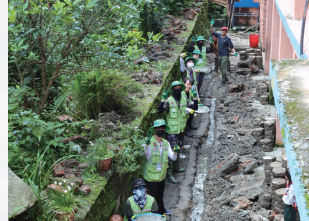
배수로 정비 노력봉사
